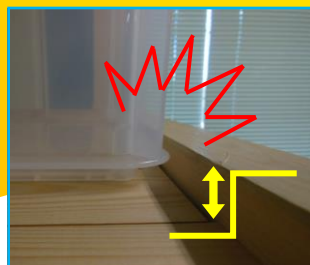
各段には段差があるため ケースが滑り落ちない
