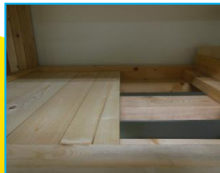
各棚は接合していないため 簡単に取り外し可能
